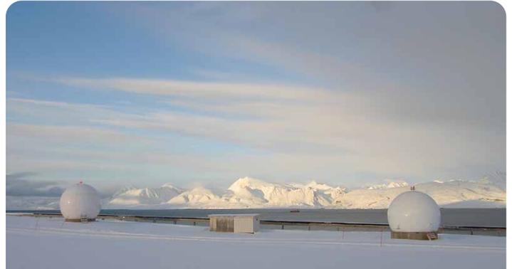
Die GFZ-eigene Empfangsstation auf Spitzbergen liegt so weit im Norden, dass die Satelliten nach jeder Erdumrundung Kontakt haben und die Daten rasch zu den Nutzern gelangen.
